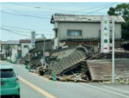
地震による甚大な被害を受けた市街の様子
